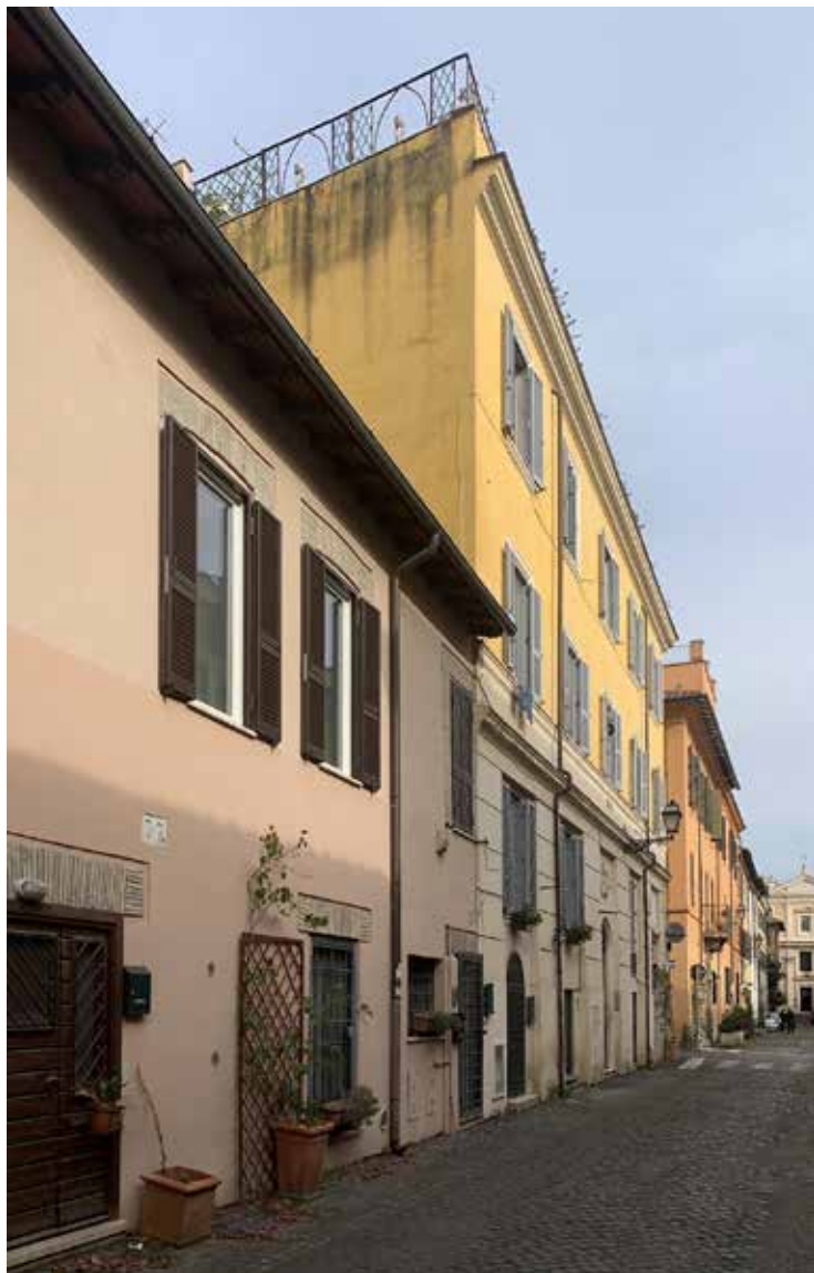
Figura 12. Unità Edilizie prospettanti su via di San Francesco di Sales (UU-A 8). Dall'osservazione delle superfici rivestite, si è supposta la sostituzione dell'intonaco originario della U.E. posta in primo piano (foto A. Martello, 2023).
